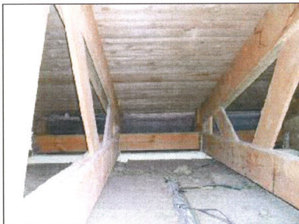
foto /31/ Dřevěné bednění na vaznících
