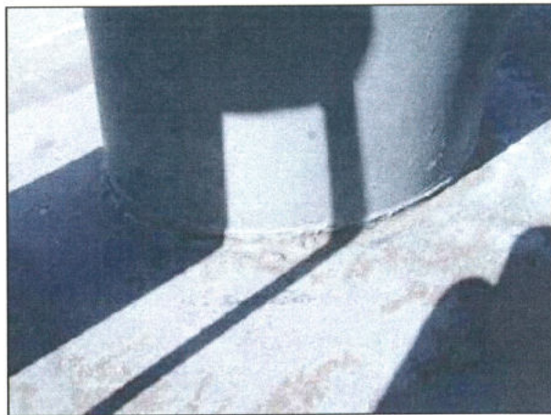
foto /35/ Napojení hlavice VZT a krytiny
