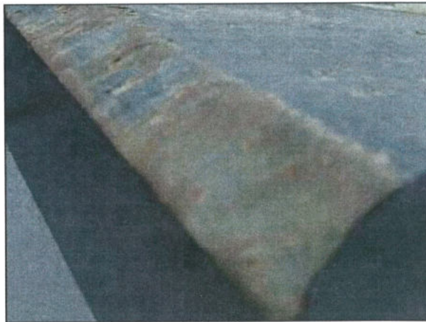
foto /30/ Lokální výskyt koroze
