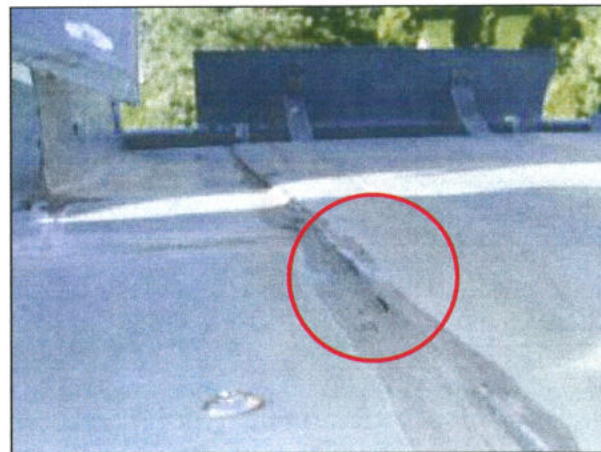
foto /28/ Netěsnosti v tmelené spáře
