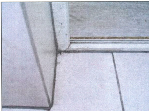
foto /37/ Ukončení dlažby u prahu dveří
