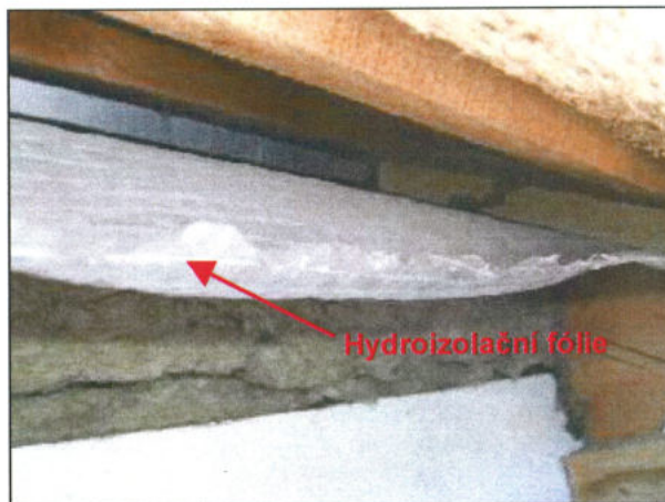
foto /17/ Ukončení hydroizolační fólie
