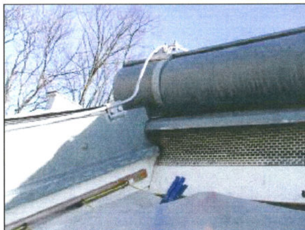
foto /25/ Pohled na okapnici a závětrnou lištu
