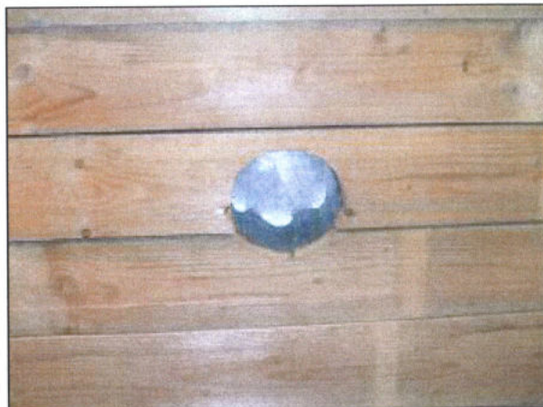
foto /33/ Odvětrávací komínek osazený v konstrukci dřevěného bednění
