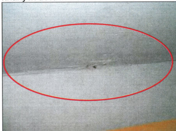
foto 1/1 Stopy po zatékání v interiéru
